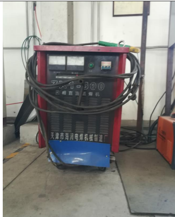
电焊机基础减振
