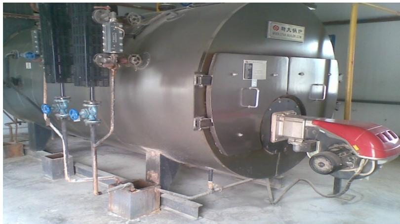
**水煮式清洗装置**：稠油清洗，蒸汽锅炉循环加热80-110℃，每池150-180根/4h
